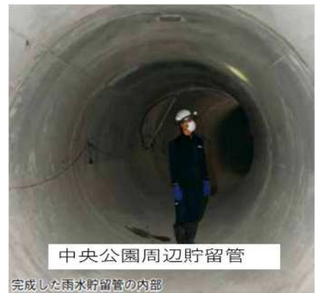
完成した雨水貯留管の内部
