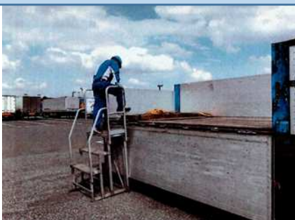
墜落・転落防止：昇降台の導入
